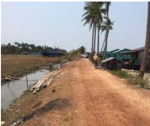
ទំនប់ការពារទឹកសមុទ្រនៅភូមិ ដីមីល ឃុំអណ្តូងទឹក ស្រុកបុទុមសាគរ ។ ទំនប់នេះប្រើប្រាស់ដើម្បីការពារការជ្រាបចូលនៃទឹកប្រៃ ។
