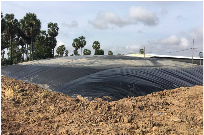
ឡដីឧស្ម័នខ្នាតមធ្យមផ្ទុកលាមកជ្រូក ក្នុងស្រុកគងពិសី ខេត្តកំពង់ស្ពឺ នៅខែធ្នូ ឆ្នាំ២០១៦
